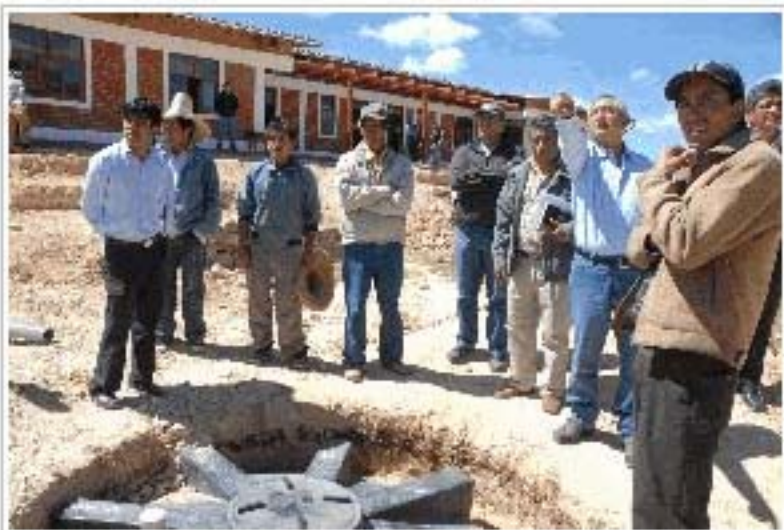
El ministro de Vivienda, René Cornejo, supervisó hoy las obras de construcción del tambo del distrito de Namora, en Cajamarca. Foto: MVCS.
