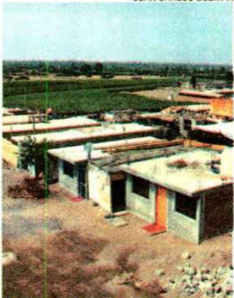
Construyen viviendas en Ica.
