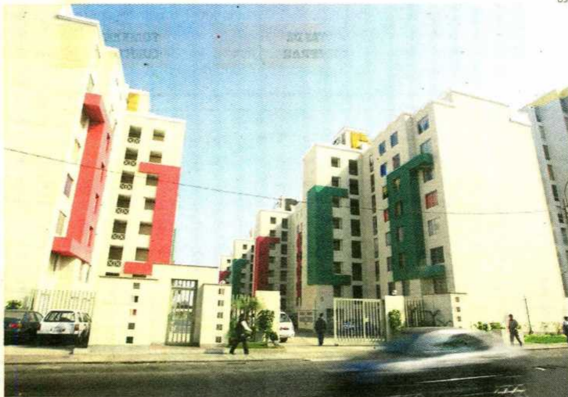
■ NUEVO IMPULSO. Fondo Mivivienda está en reestructuración, anunció la Asociación de Bancos.
