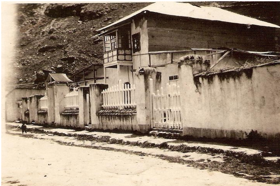
Antigua vivienda en la calle 28 de Julio - Huachón
